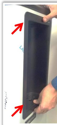
8. Con pannello perfettamente adiacente al mobile spingere delicatamente verso il basso e rimontare la vite di fissaggio.
